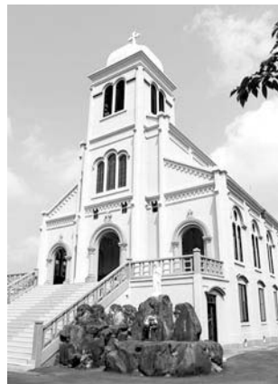
図16 紐差カトリック教会堂（鉄筋コンクリート造） 設計・施工：鉄川與助 1929（昭和4）年 長崎県
