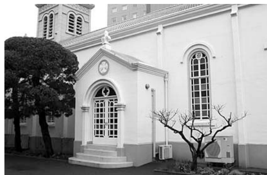
図18 2代目（現在）の手取教会堂の側壁に設けられた出入口
