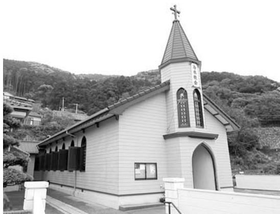
図11 冷水カトリック教会堂（木造） 設計・施工：鉄川與助 1907（明治40）年 長崎県
