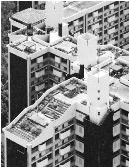
図9 空中歩道によって繋がれた屋上庭園
