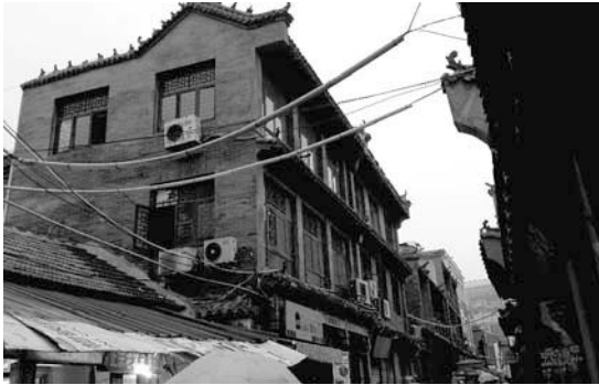
図9 芙蓉街 低く垂れ下がった電線
