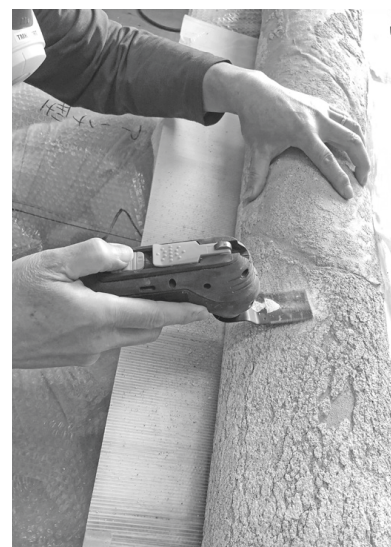
図9 電動サンダーで裏面の漆喰除去中
