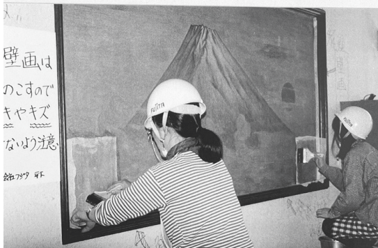
図4 ストラップのための寒冷紗貼り
