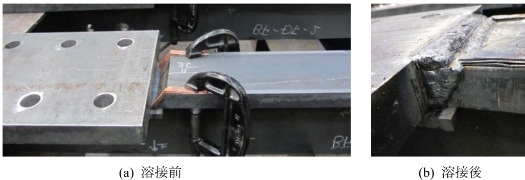
図 3.4 銅板挿入タイプ加工状況
